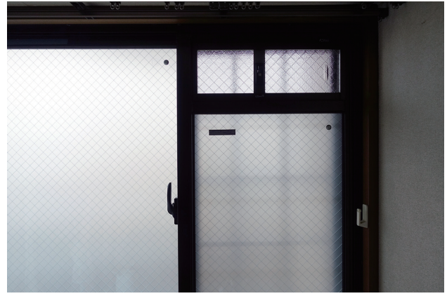
北側居室のうち、一室は納戸にしている。共用廊下に面したコーナー出窓は結露が激しく、しまっている衣類や書籍が「ベタベタになって困っていました」
